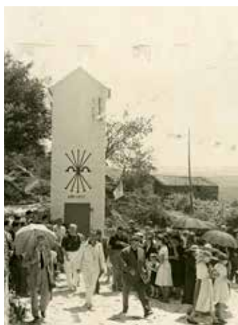
Imaxe 12. O gobernador civil, Rafael Fernández Martínez, ataviado co uniforme do Movimiento, na inauguración dun transformador eléctrico na parroquia de Moimenta. Na torre pode verse a simboloxía do réxime.
