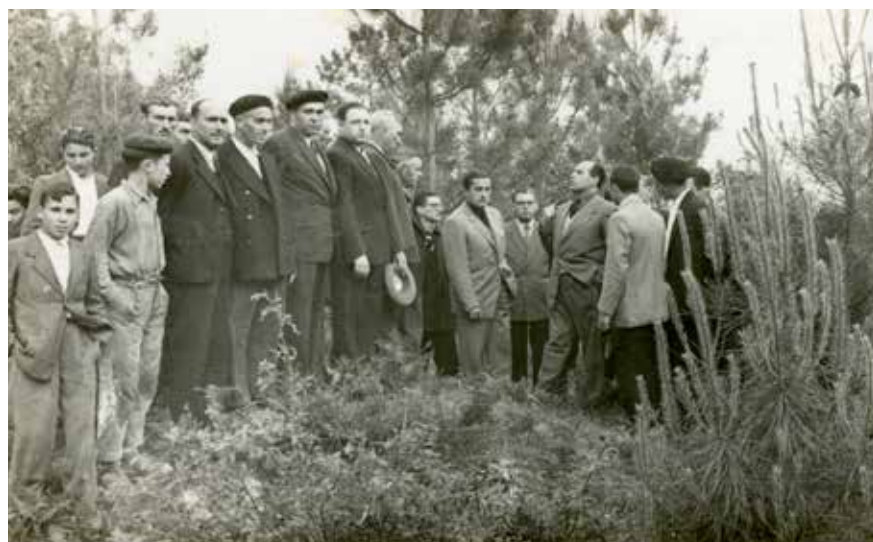
Imaxe 22. O gobernador civil, Palao Martialay, observando as obras de regadío en Ponteareas en xullo de 1951.
