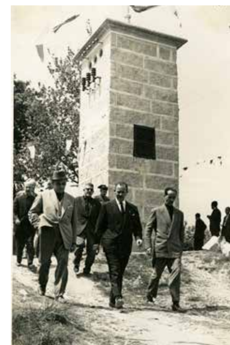
Imaxe 14. Inauguración dun transformador eléctrico en Soutelo, o 1 de maio de 1958, por parte do gobernador civil Rafael Fernández Martínez. Na esquerda, León Terrados Jarabo, subxefe provincial do Movimiento; no centro, o gobernador. Tras el camiña Manuel Crespo Alfaya. Outros cargos que non identificamos pero que formaban o séquito eran Pedro Ruibal Sabio (tudense e enxeñeiro xefe da Delegación de Industria), Rueda Muñiz, enxeñeiro de Colonización, e Fernández Eiriz (xefe de Acción municipal).
