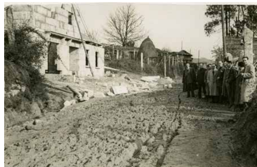
Imaxe 8. Inspección das obras do Centro de Higiene Rural e casa do médico, situado na Esfarrapada.
