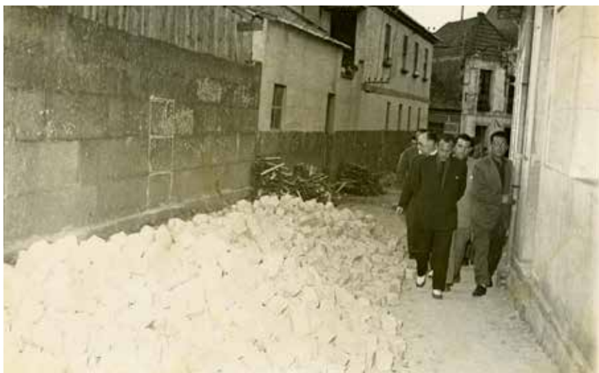
Imaxe 3. Visita do gobernador Fernández Martínez á que, na altura de 1957, era a travesía de Peralto, no Grove, durante as súas obras de lastrado. As madeiras do fondo anuncian a situación do serradoiro de Pío Torres.
