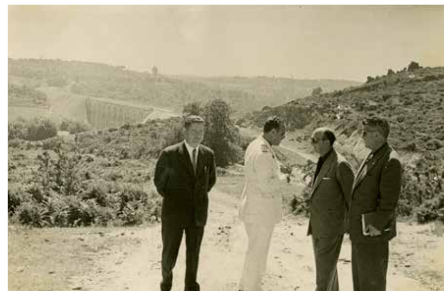
Imaxe 5. Gobernador e autoridades na ponte da liña férrea Ourense-Santiago en construción.
