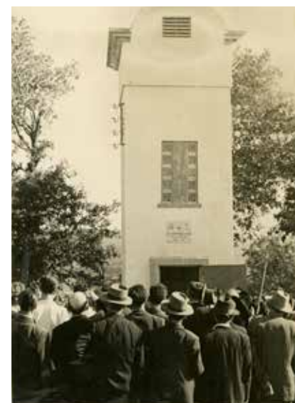
Imaxe 15. Veciñanza de Río (Rodeiro) diante do transformador que vén de inaugurar o gobernador.
