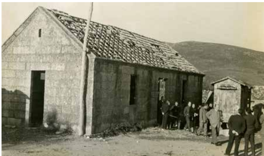
Imaxe 7. Un momento do percorrido polas obras da calle A .
