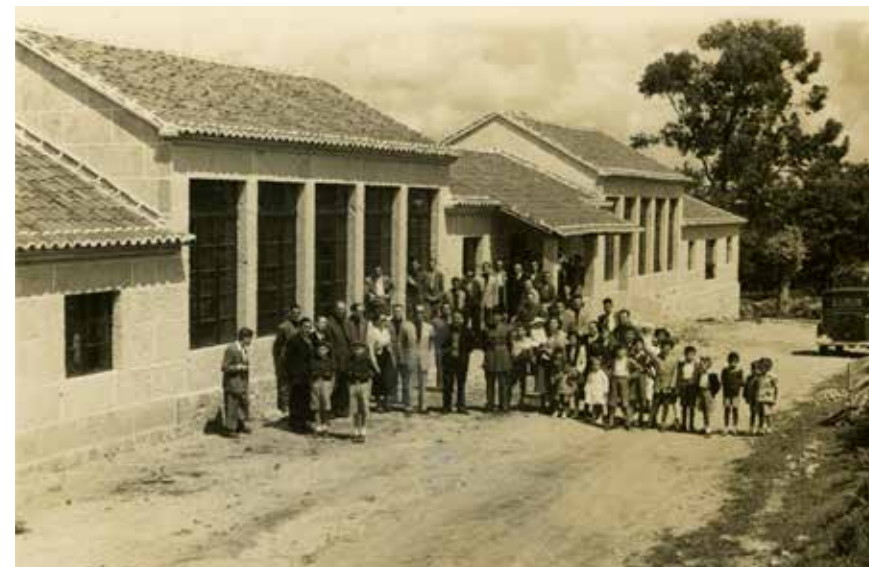
Imaxe 4. Un momento da visita ás obras da Casa de la Hermandad de Labradores y Ganaderos de Silleda.
