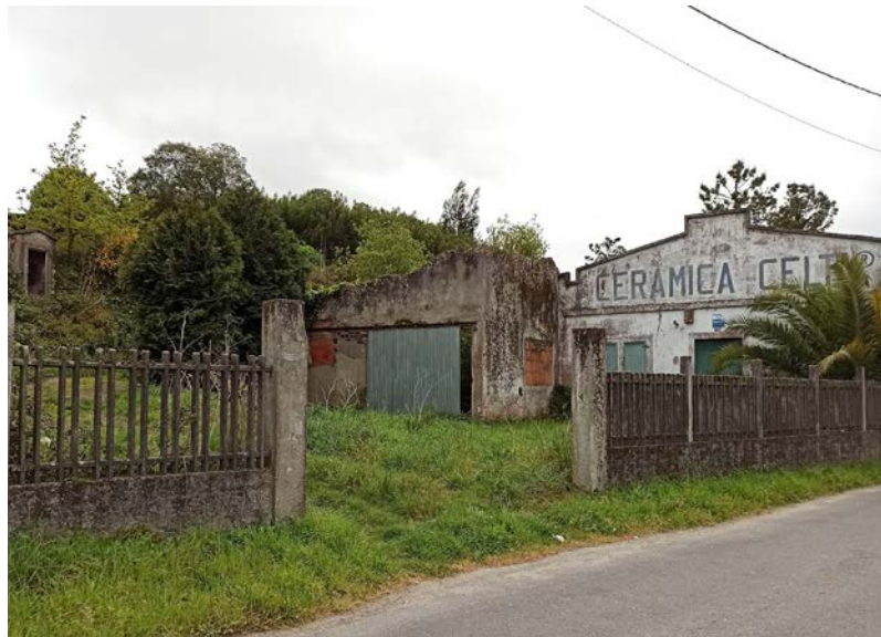
Imaxe 17. Estado actual das instalacións de Cerámica Celta de Pontecesures.
